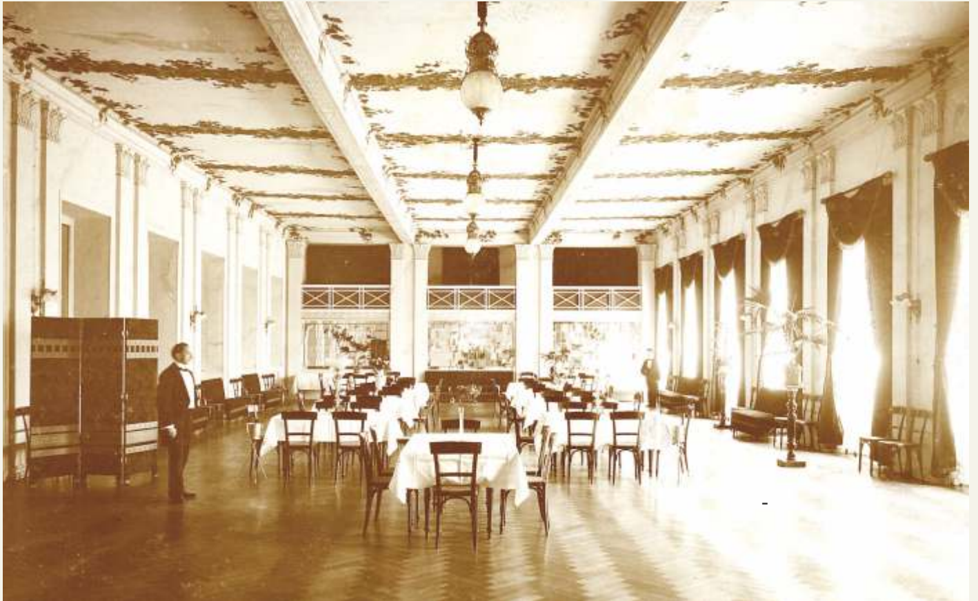
Blick in den großen Saal, der vom Architekten Johann Conrad Bromeis in der Raumkunst des Klassizismus und Empire gestaltet wurde.
